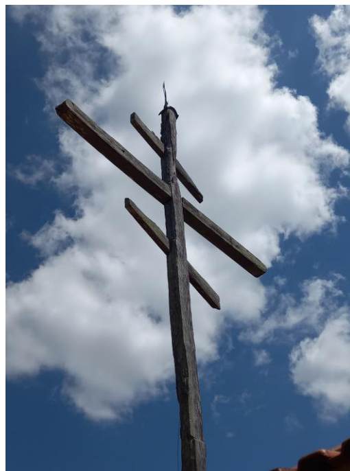
Fotos 05: Braços do Cruzeiro com ressecamento, fungos, frestas e lascas. Autoria: Alexandra Sales | Data: 16/09/2025
