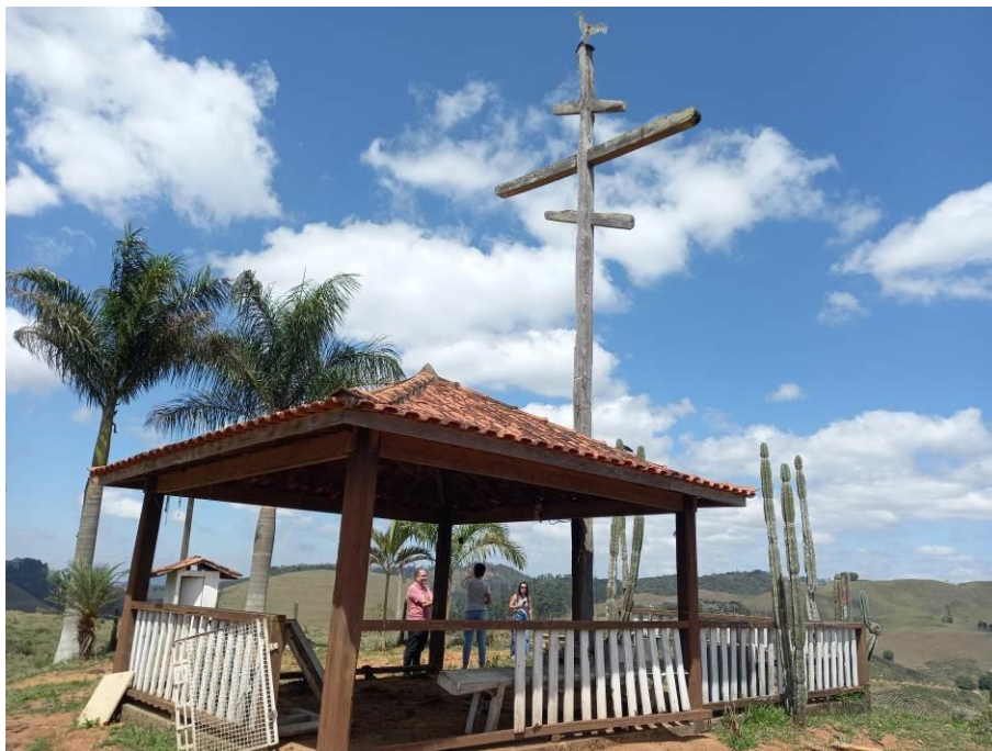
Foto 12: Pintura da cerca com desgastes gerais. Autoria: Alexandra Sales | Data: 16/09/2025
