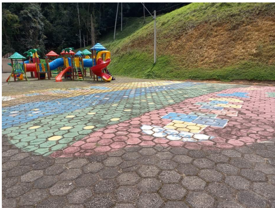
Foto 31: Playground em bom estado de conservação. Autoria: Alexandra Sales | Data: 16/09/2025
