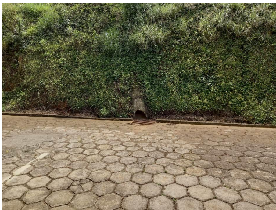
Foto 08: Canaleta em bom estado. Autoria: Alexandra Sales | Data: 16/09/2025
