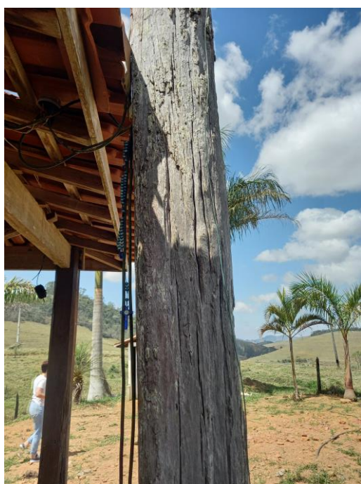
Fotos 02: Tronco com frestas, ressecamento, fungos e furos causados por xilófagos. Autoria: Alexandra Sales | Data: 16/09/2025
