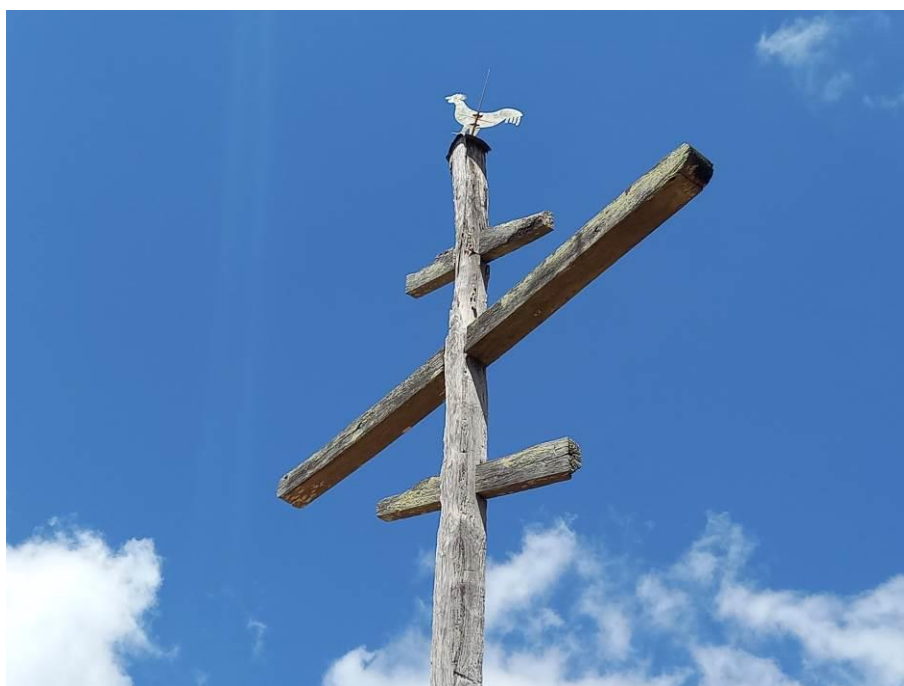
Fotos 08: Detalhe dos braços do Cruzeiro com ressecamento, fungos, frestas e lascas.
