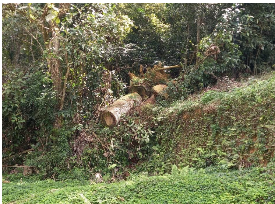
Foto 23: Pedacos do tronco da árvore que caiu sobre a edificação dos banheiros. Autoria: Alexandra Sales | Data: 16/09/2025
