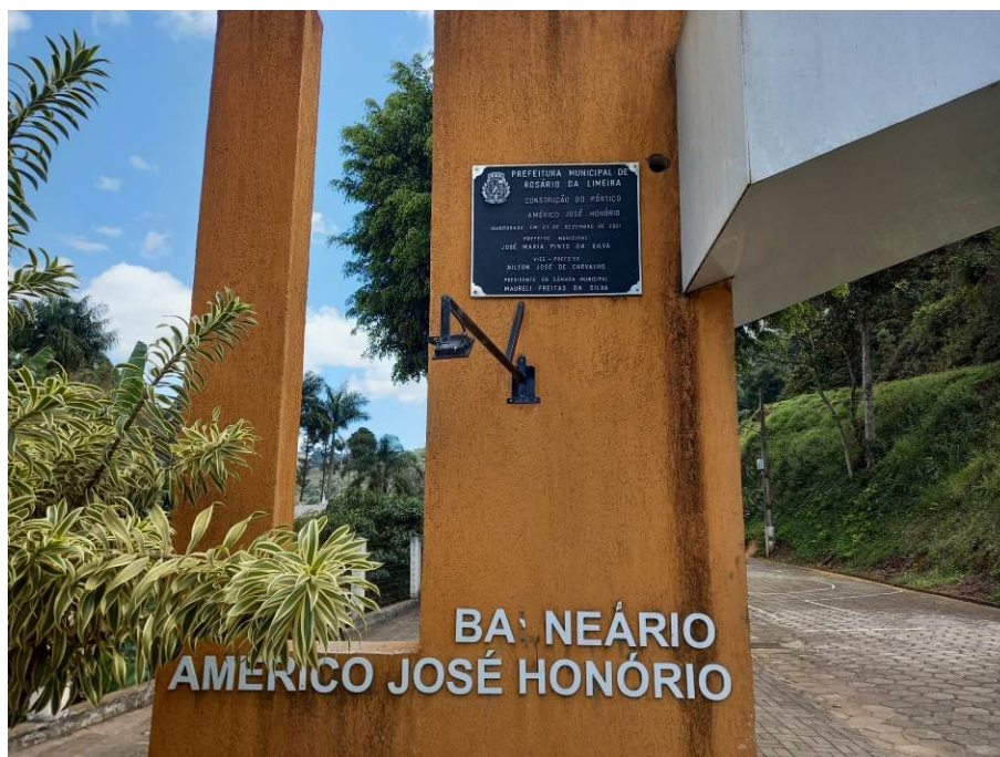
Foto 02: Placa do pórtico em bom estado. Autoria: Alexandra Sales | Data: 16/09/2025
