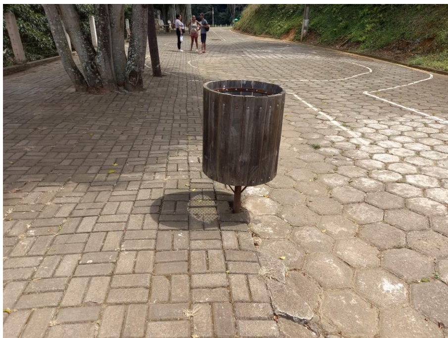
Foto 16: Lixeira com ressecamento da madeira. Autoria: Alexandra Sales | Data: 16/09/2025
