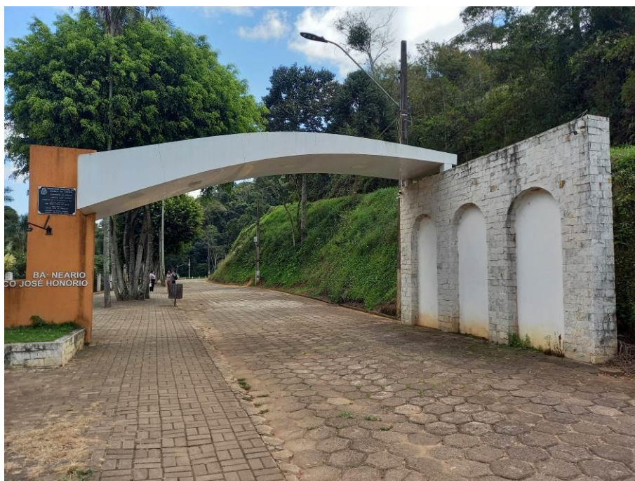
Foto 15: Diferentes tipos de pavimentação do piso, desníveis e escurecimento. Autoria: Alexandra Sales | Data: 16/09/2025
